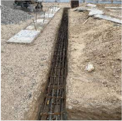
Суурийн бүс бетон арматурчлал
