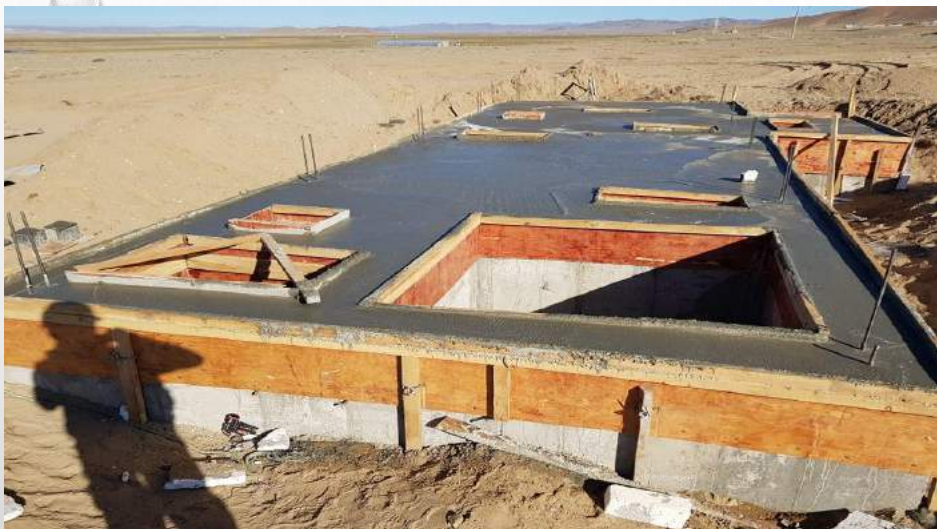
Бетон танкны хучилт
